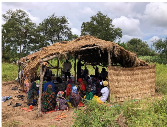
A primeira sala de aula feita de materiais locais em Naray, Chade.
